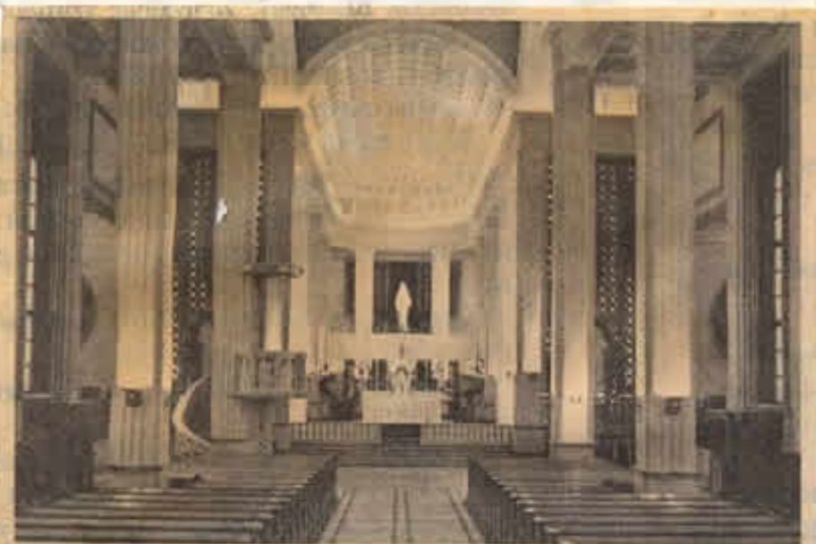
Wnętrze Kościoła w Niepokalanowie
